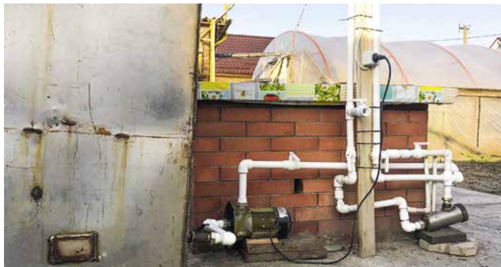
Установка оборудования при выращивании томатов
